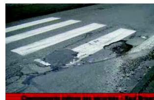
Cheminements piétons peu sécurisés - Neuf Brisach
