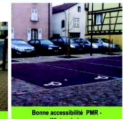
Bonne accessibilité PMR - Wintzenheim
