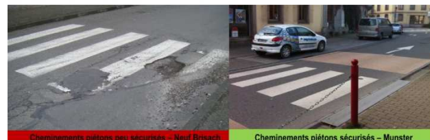
Chemements piétons peu sécurisés - Neuf Brisach
