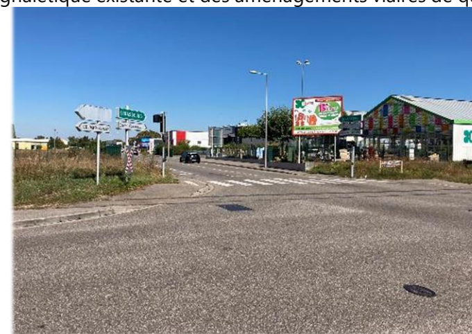
Une signalétique existante et des aménagements viaires de qualité
