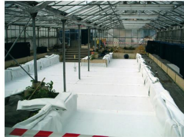
Bassin enterré de 60 m³ de récupération des eaux pluviales et de réutilisation pour l'arrosage des serres de La Courneuve, vues pendant et après les travaux
