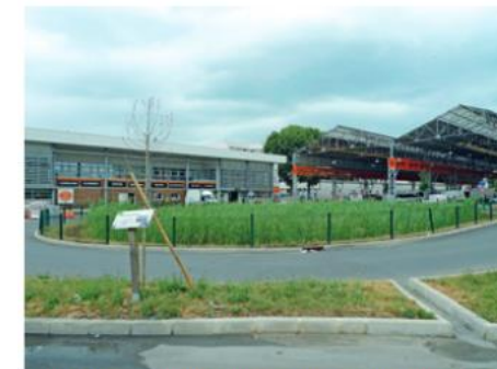
Bassin de récupération des eaux de voirie, Point P, Aubervilliers
