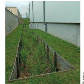
Noue des eaux de toiture, Point P, Aubervilliers
