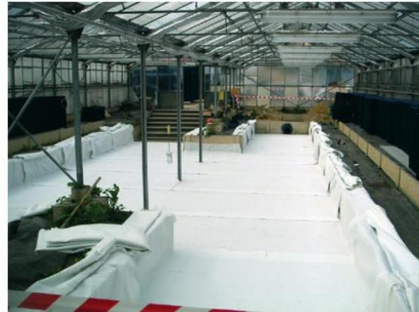
Bassin enterré de 60 m<sup>2</sup> de récupération des eaux pluviales et de réutilisation pour l'arrosage des serres de La Courneuve, vues pendant et après les travaux
