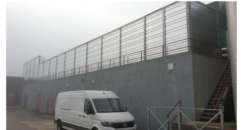
*Cloison acoustique pour traiter les bruits à la source de l'industrie UNITED CAPS (batterie de ventilateurs et groupes froid)*
